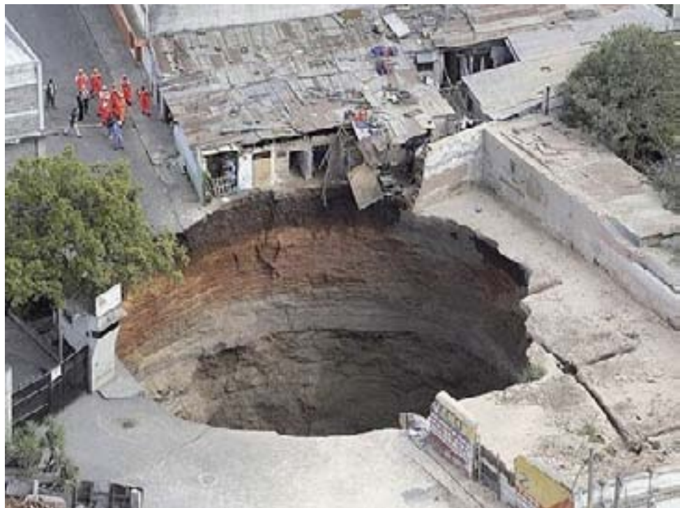
Afundamento por colapso do solo induzido pela dissolução e lavagem do solo fino.
