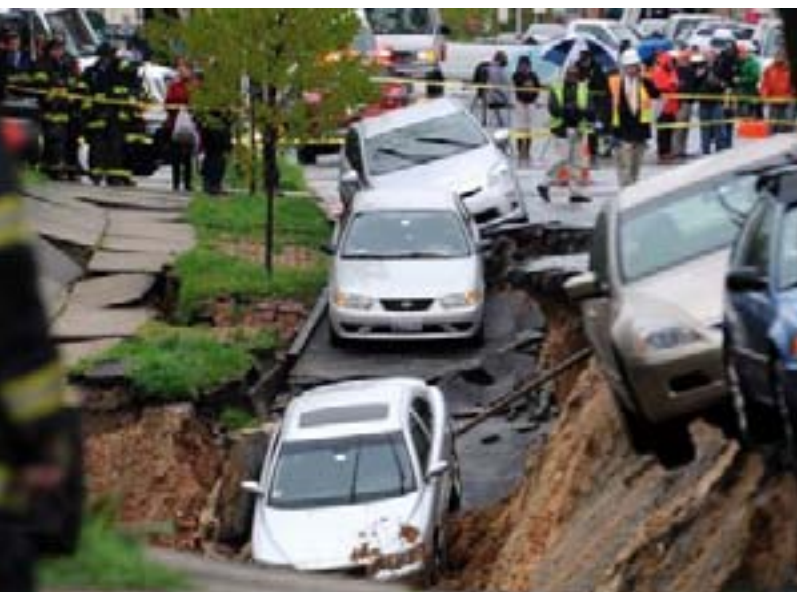
Colapso do solo após intensas chuvas.
