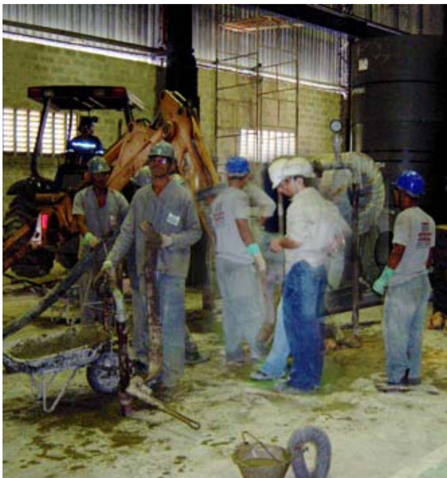
Tratamento do solo sob esta unidade industrial.
