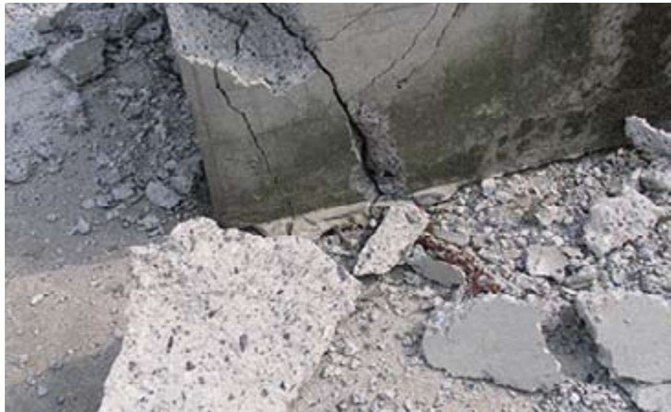
Solos expansivos causam grandes tensões nas estruturas, suficientes para provocar deslocamentos.
