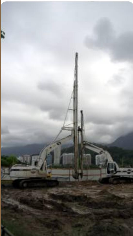
*Foi necessário atravessar camadas de aterro com matacões de até 12m de espessura para se chegar ao depósito de solo mole que chegava à profundidades de 30m.*
