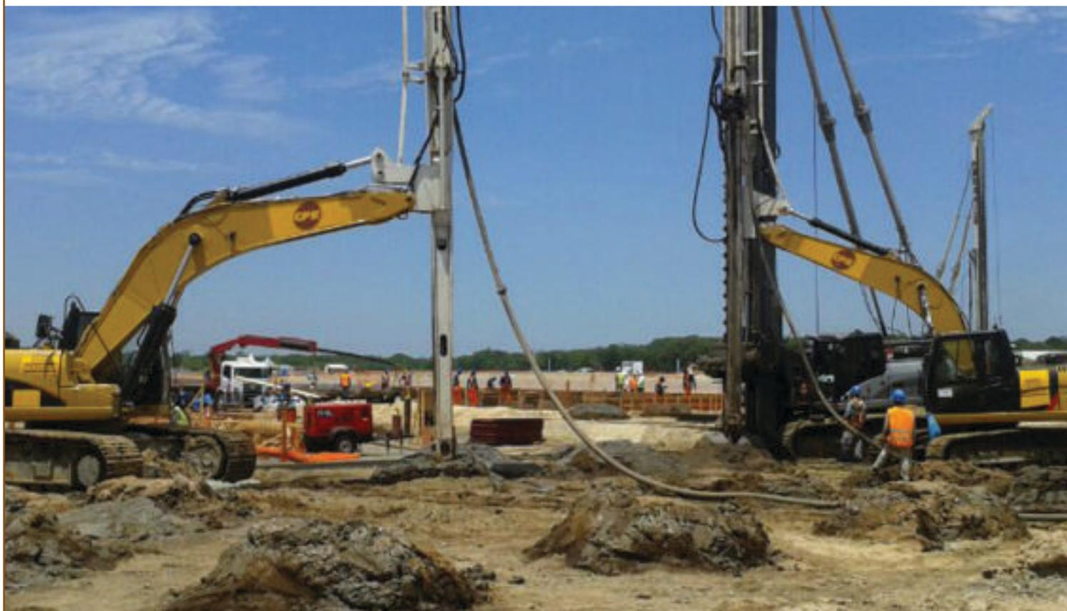
*Foram feitos ensaios antes e após tratamento CPR, entre 6,0 m e 15,0 m de profundidade. A análise dos resultados mostrou que, baseado nas análises pressiométricas e piezométricas, houve melhoria geotécnica significativa no solo tratado, eliminando recalques projetados e aumentando a capacidade de carga do solo de fundação. Camadas do subsolo que antes possuíam compacidade fofa adquiriram, após o tratamento, ganho de rigidez, equivalente a uma areia compacta.*
