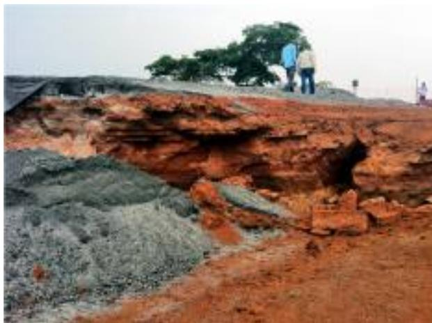
**Ruptura do talude, devido a elevação do greide, ao lado da estrada original. Presença de solo mole sem tratamento.**
