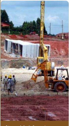
O terreno de fundação era a Lagoa Billings, com depósitos de solo mole que chegavam a 12m de profundidade. O solo tratado receberia 10m de altura de aterro para construção do entroncamento rodoviário.
