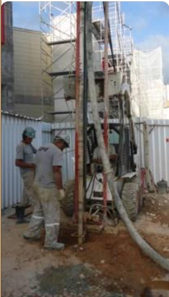
*O Permeation Grouting preenche os poros do solo (areias) sem causar movimento ou fraturamento hidráulico. Basicamente, tem a ver com a substituição da água e do ar, presentes entre partículas do solo arenoso, fraco em resistência, por geogROUT pré-dimensionado, utilizando-se baixas pressões. Essa técnica também é utilizada com sucesso na redução ou interrupção da permeabilidade em solos, rochas e maciços de barragens, aplicando-se geogROUTS de reação ultra-rápida.*
