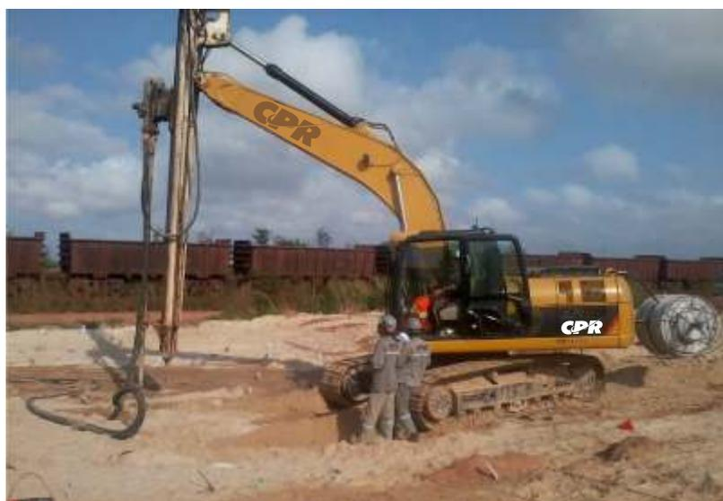
Cravação de geodrenos. Ao fundo a ferrovia Carajás. Todo o solo de fundação é composto por um profundo depósito de solo mole. O novo aterro e as novas cargas poderiam causar desequilíbrio na delicada condição sub-superficial e comprometer a antiga ferrovia.
