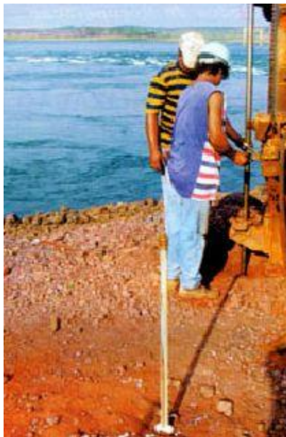
Legenda: Injeção em barragem
