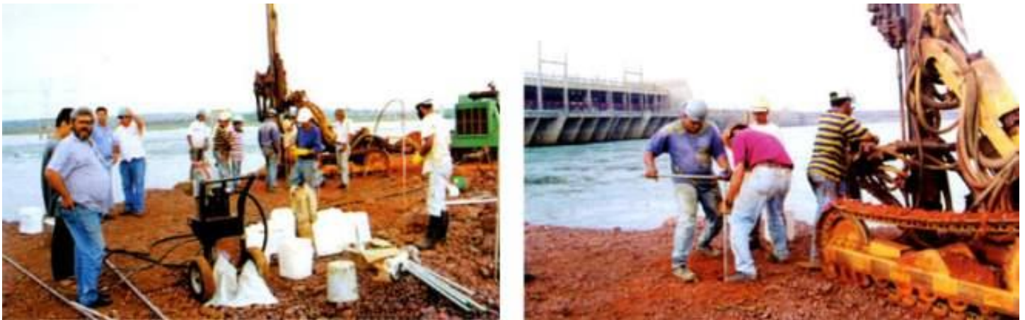
Legenda: Barragem (execução)
